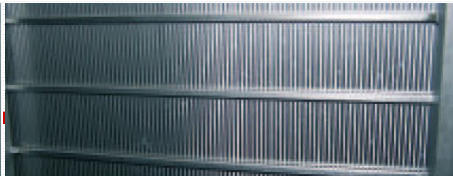
Fina rešetka od vertikalnih šipki (š=5-20mm)
